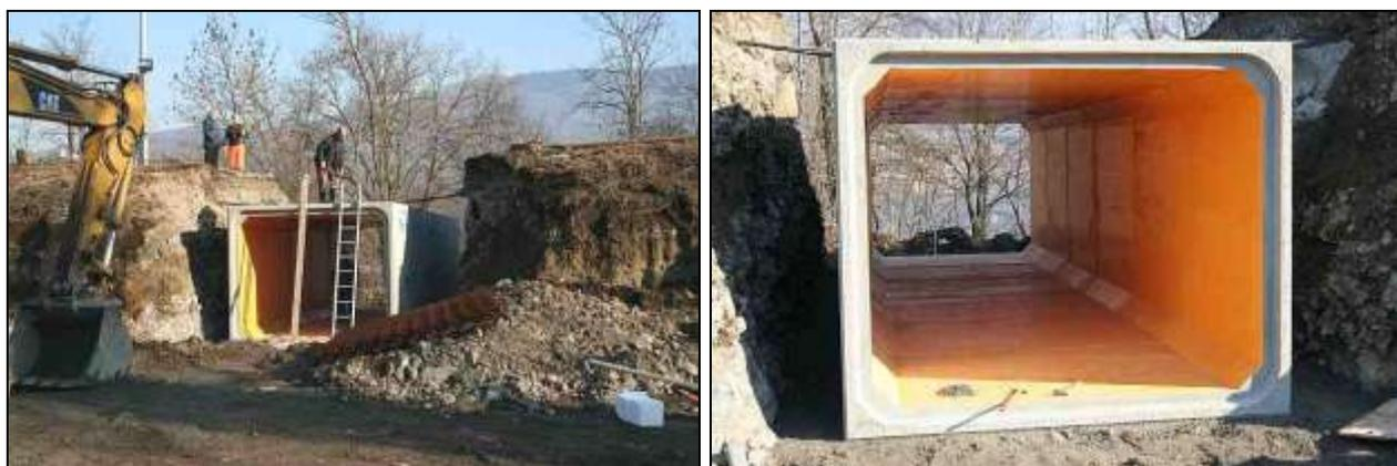
Fig. 2.10 - Apertura della strada e posa scatolare
