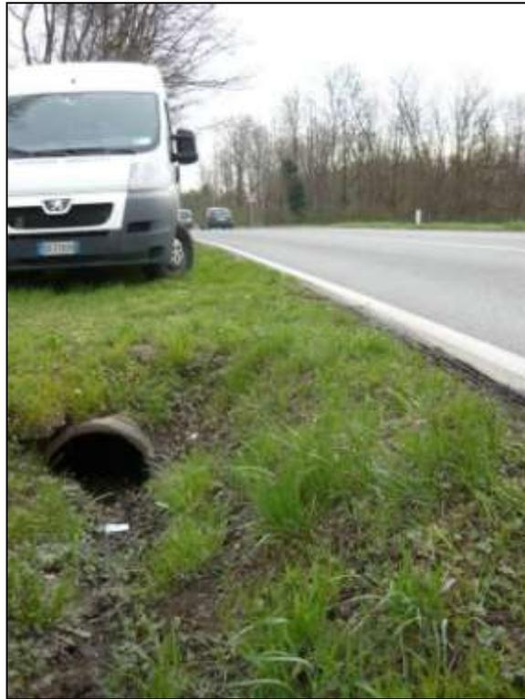
*Fig. 2.74 - Inizio porzione interrata del canale (diametro tubo in cls: 50 cm)*
